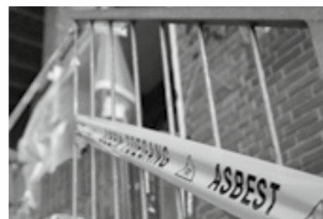
...terwijl er binnen hard wordt gewerkt aan het verwijderen van asbest.
