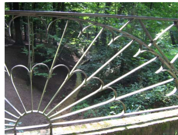
Doorkijkje door de brugleuning van de laatst overgebleven monumentale brug op het landgoed Mariëndaal
