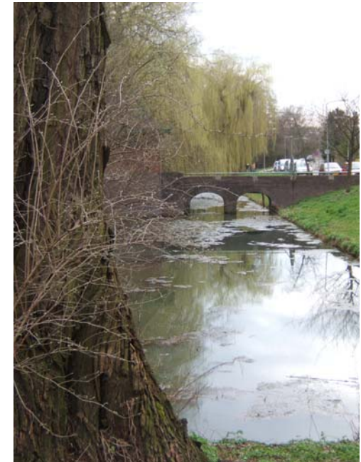
De watergang langs de Schavenmolenstraat met de toegangsbrug naar het gemaal
