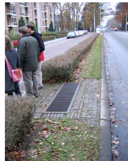
De put tussen de Velperweg en de ventweg bij Wellenstein
