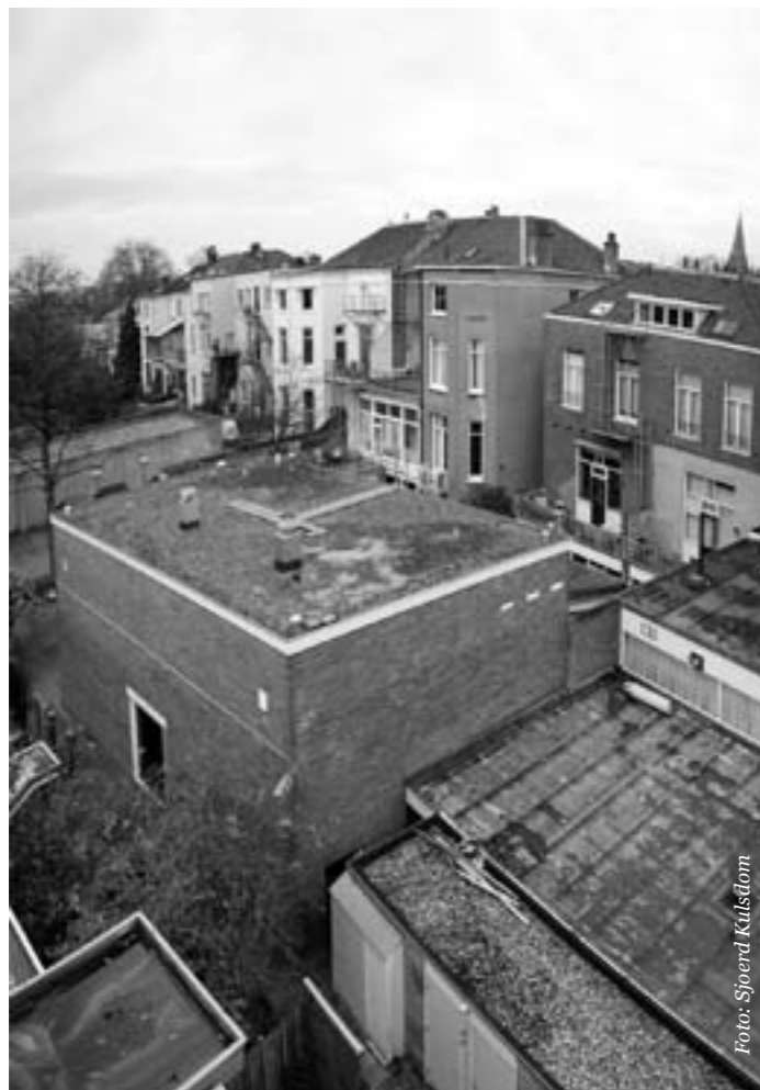
De 'toneeltoren' van het theater tussen de woningen, gezien vanaf de flat in de Dijkstraat.
